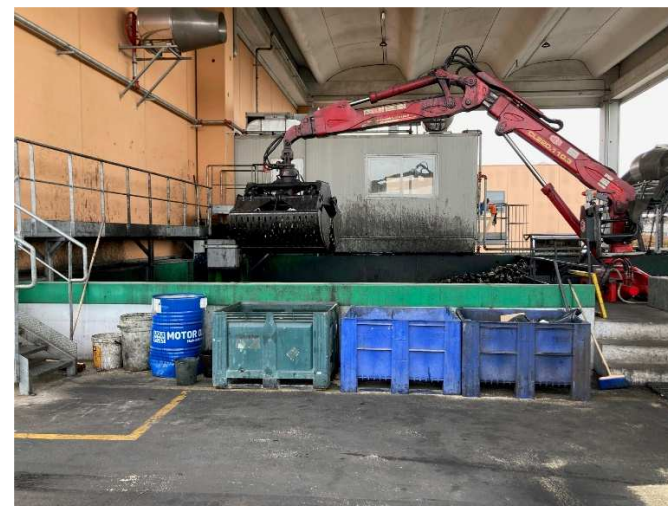
Foto 4: Area G, fasi di carico filtri olio
