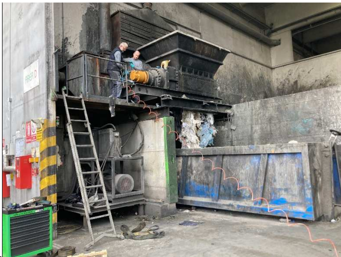
Foto 1: Area D, fasi di manutenzione trituratore
