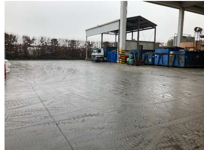
Foto 2: Area I, stoccaggio in container rifiuti prodotti
