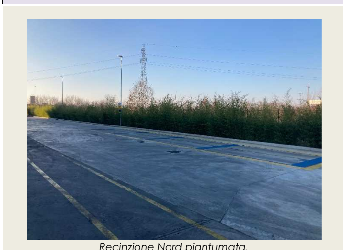
Recinzione Nord piantumata.
