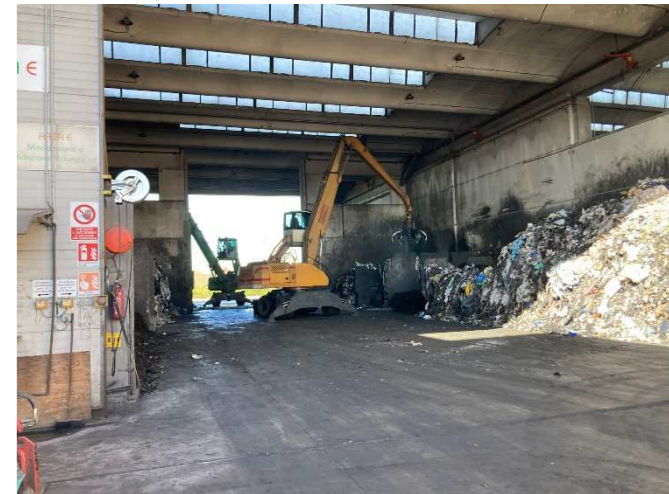
Foto 2: Area E, fasi di miscelazione
