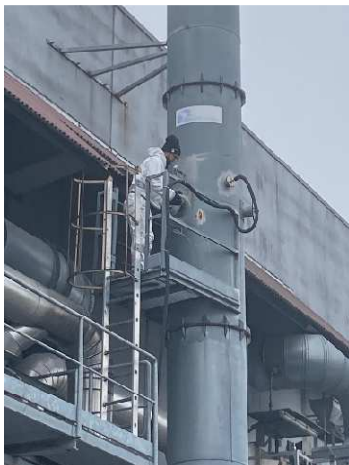
Foto 1: fasi di monitoraggio emissioni, Area F. L'impianto di aspirazione era attivo
