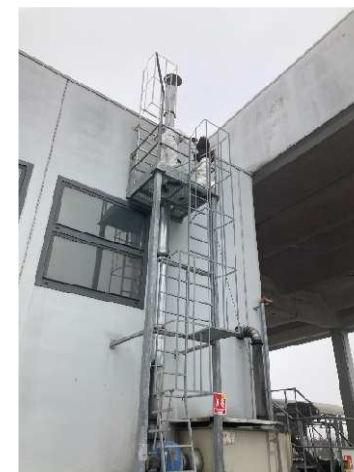
Foto 2: fasi di monitoraggio emissioni, gruppo macinazione filtri olio, Area G. L'impianto di aspirazione era attivo
